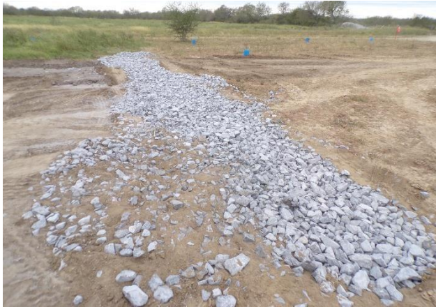
Foto 8. Zanja recién terminada enero 2019.
