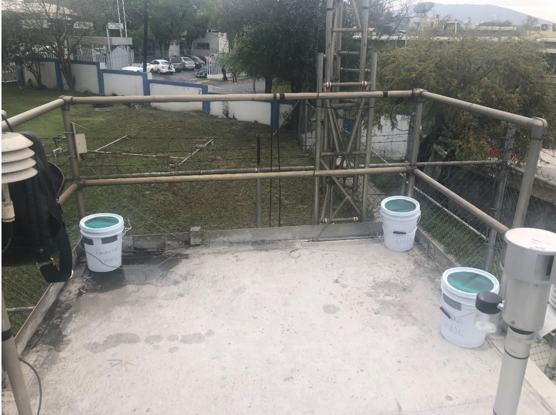
Fotografía de los colectores de muestreo de lluvia colocados en el techo de la estación Obispado del Sistema de Monitoreo Ambiental (SIMA), tomada el 12 de febrero de 2019 después de haber realizado una de las primeras colectas de muestra de lluvia en el sitio.
