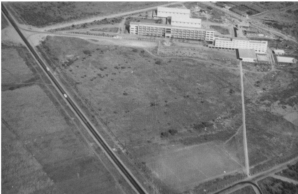
Ilustración 22: Construcción del campus del ITESM en 1948 a un costado de la Carretera a México.
