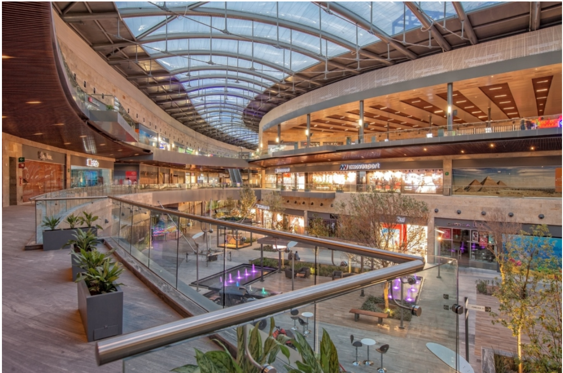
Centro comercial Paseo La Fe
