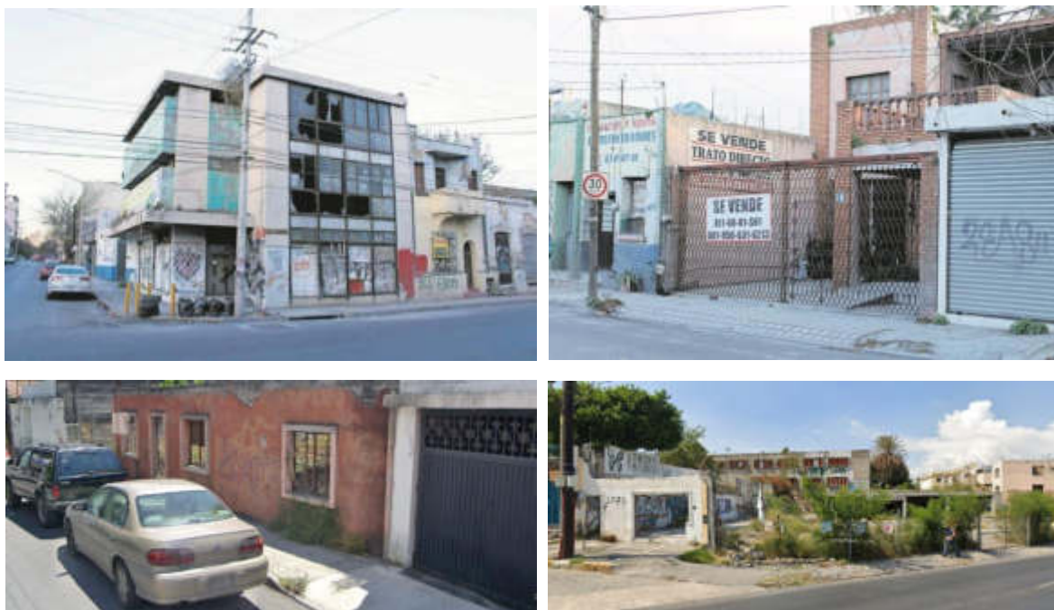
Figura 1.1: Vivienda Abandonada Centro Monterrey. Elaboración por medio de Google Maps.
