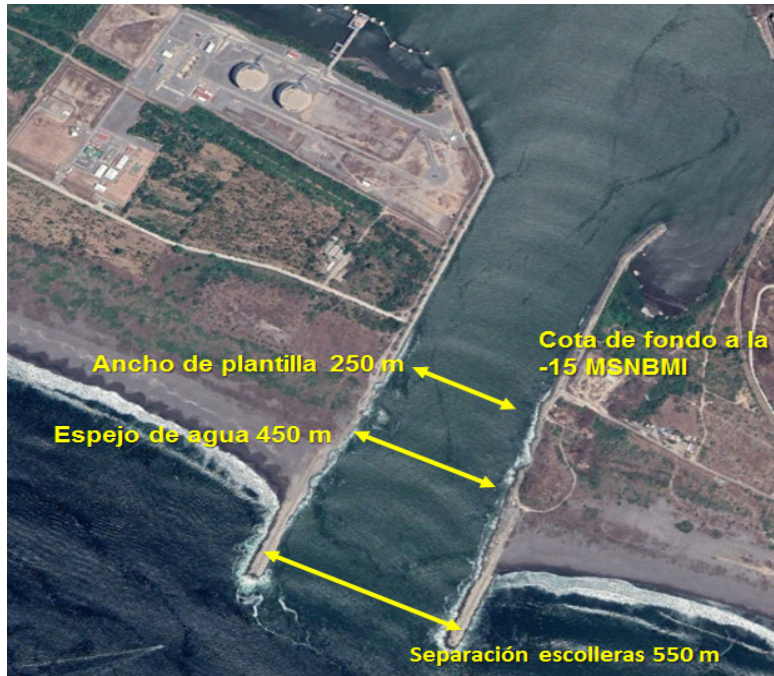
Figura 1.- Canal de Tepalcates en el vaso II, después de su reapertura (2012).
