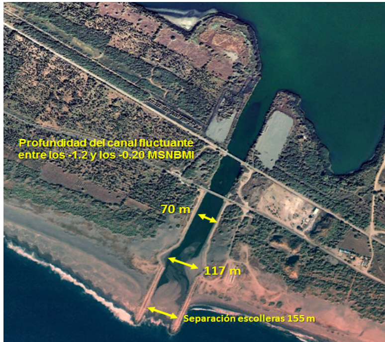
Figura 2.- Canal de Tepalcates en el vaso II, antes de su reapertura (2008).
