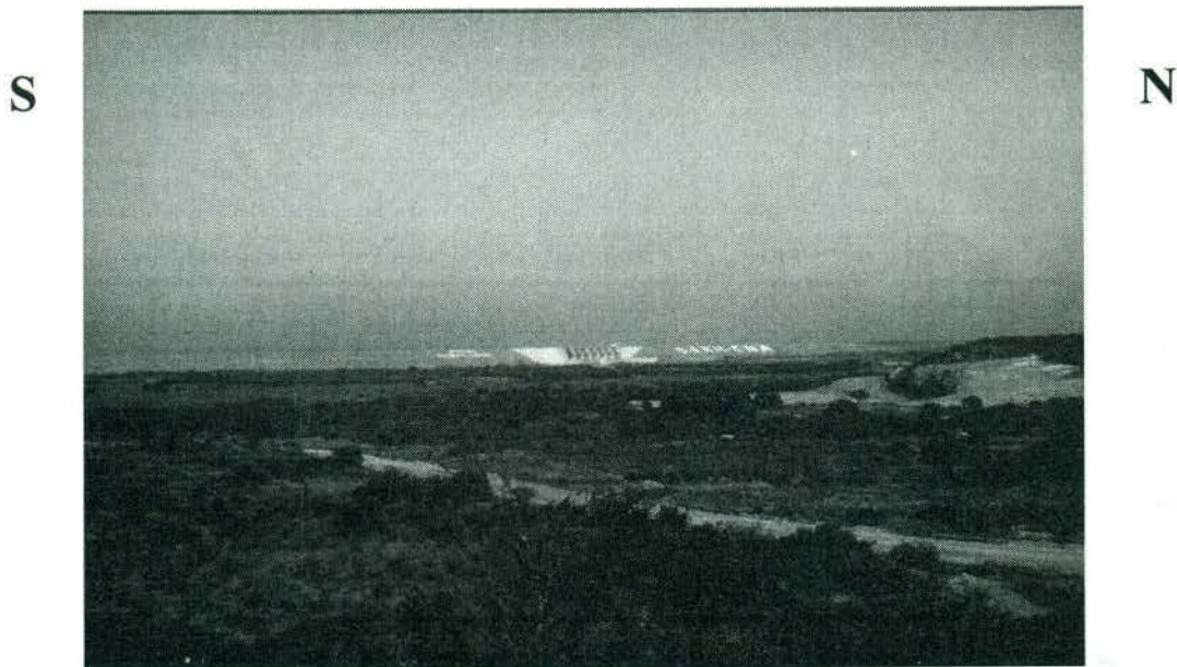
Fig. 1.1 Presa El Cuchillo Solidaridad, vista aguas arriba.
