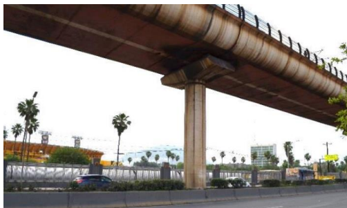
Figura 29. a) Línea dos del metro con presencia de Hollín.,
