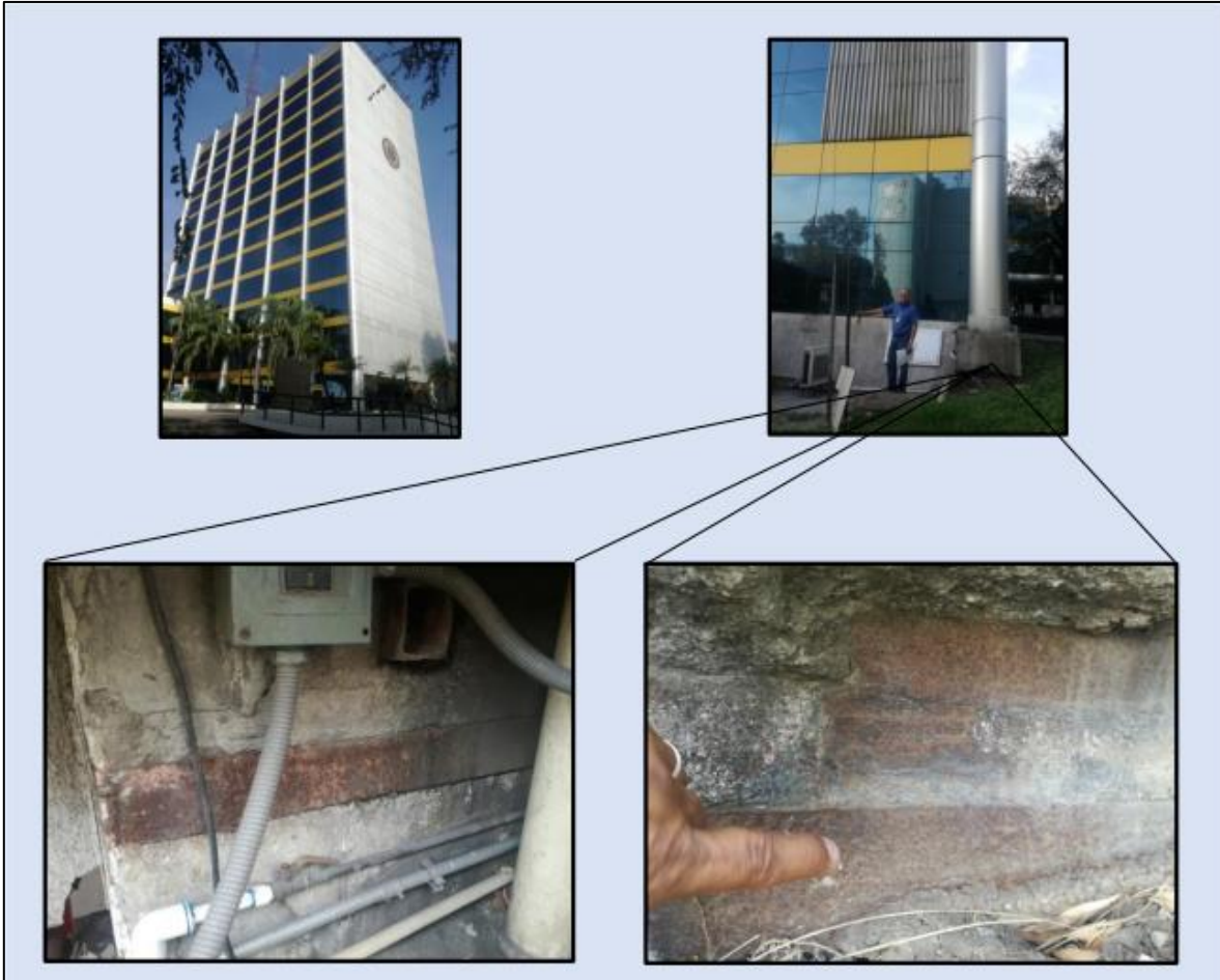
Figura 31. Elementos de acero de la estructura de la Torre de la Rectoría afectados por la corrosión (Pérez, 2019).
