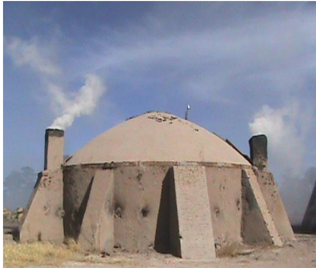
FIGURA 4. Horno de ladrillo para la elaboración de carbón vegetal.
