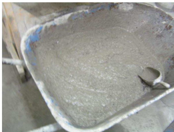
Figura 44.-Concreto vertido en carretilla.
