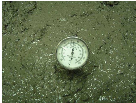
Figura 45.- Medición de la temperatura en el concreto fresco.
