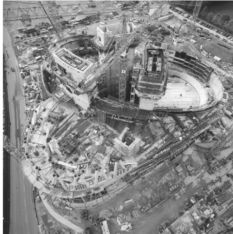
Figura 4. Estructura de concreto reforzado. Construcción de Museo Mercedes Benz, Stuttgart, Alemania.
