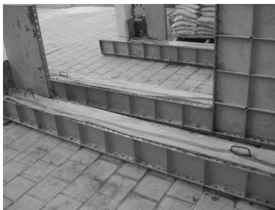
Figura 22. Curado de las vigas.
