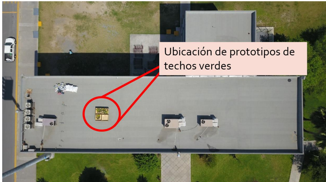
Figura 3.5. Ubicación de prototipos de techos verdes extensivos en el techo del edificio de posgrado del IIC de la UANL.
