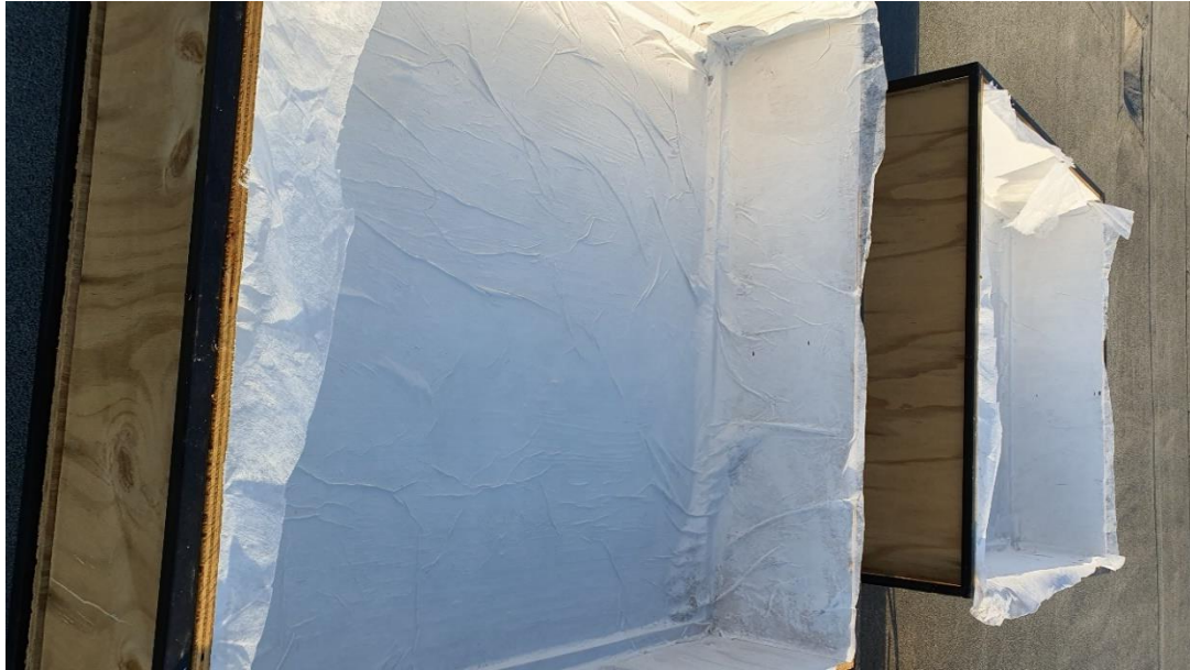
Figura 3.8. Capa impermeable. Aplicación de sellador impermeable blanco fibratado de marca Thermo-tek 19 con duración de 5 años.
