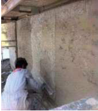
Figura 1.26 a) Colocación de concreto de cáñamo en el sistema de techado, b) Colocación de concreto de cáñamo en muros, c) Recubrimiento con mortero de cáñamo en muros [99].
