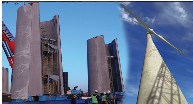
FIGURA 2.19: Torres de hormigón.
