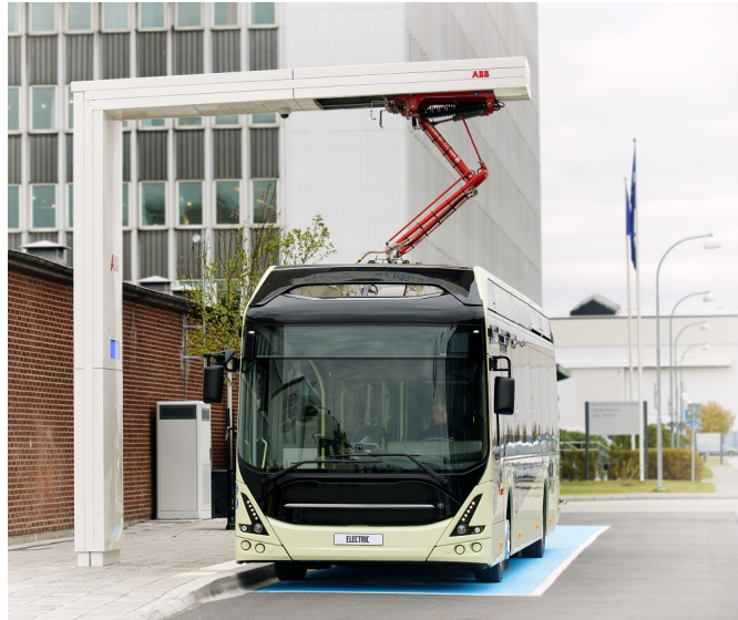
Figura 2: Autobús eléctrico realizando una carga rápida mediante pantógrafo en estación de recarga
