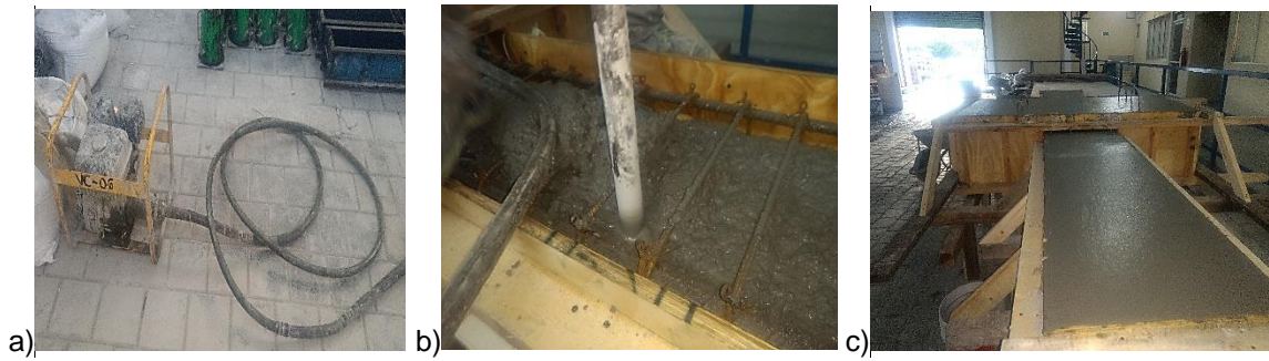
Figura 43. a) Vibrado del concreto, b) Esparcimiento del concreto, c) terminado final.
