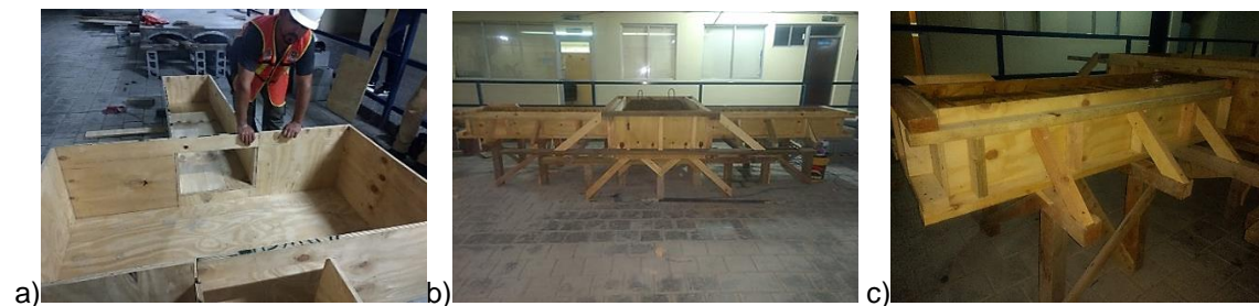
Figura 39. a) Armado de la caja, b) Colocación de soportes laterales, c) Cimbra terminada.
