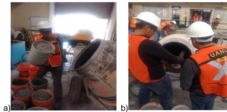
Figura 42. a) Realizando la mezcla, b) Colocación del aditivo a la mezcla de concreto.
