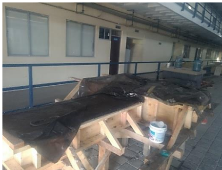
Figura 44. Colocación de plástico, para evitar pérdida de humedad.
