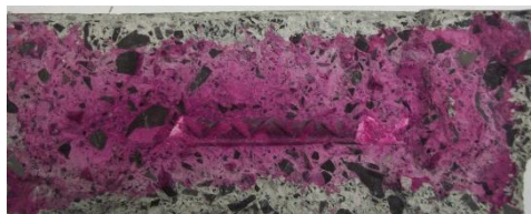
b) Carbonatación parcial (CP)
