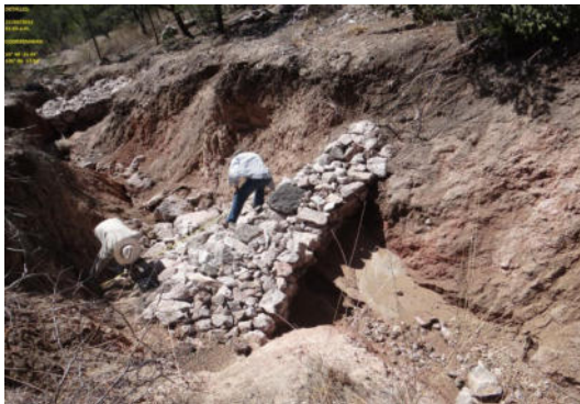
Presas Filtrantes de Piedra Acomodada
