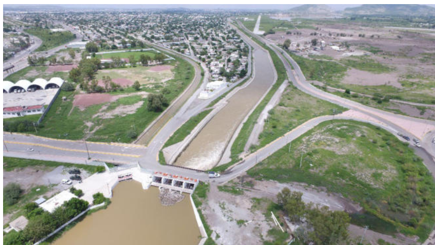
Figura 58 Canal Principal Sacramento Distrito de Riego 017 Región Lagunera Fuente: CONAGUA Organismo de Cuenca Cuencas Centrales del Norte 2016
