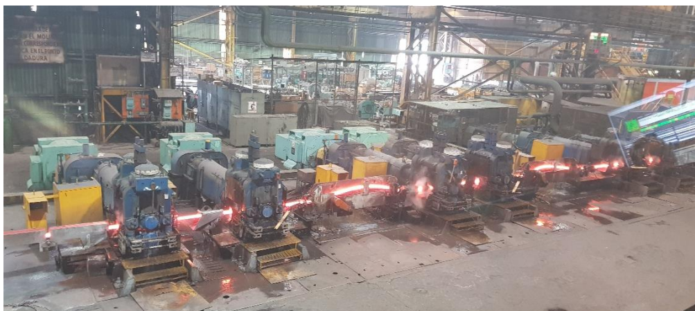
Figura 3.1. Sección de desbaste en línea de laminación de productos largos planta Ternium Puebla.
