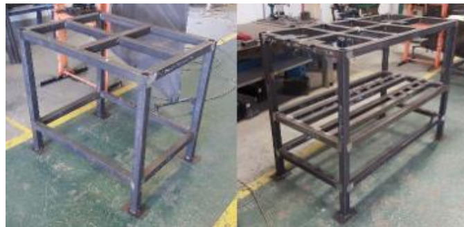
Figura 37. Estructura completa de mesa 1 (izquierda) y mesa 2 (derecha) con sus respectivas placas soldadas.
