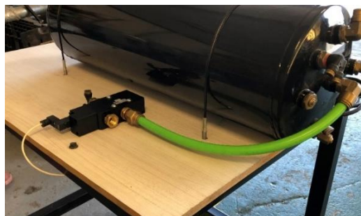
Figura 67. Electroválvula instalada en la mesa 1.
