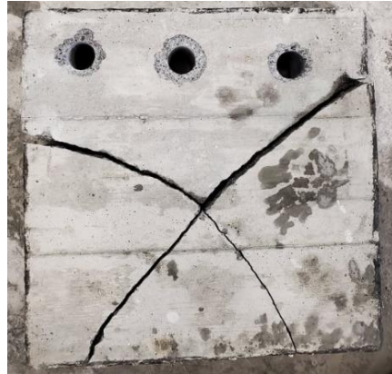
Figura 22.- Zona de extracción de núcleos de concreto.
