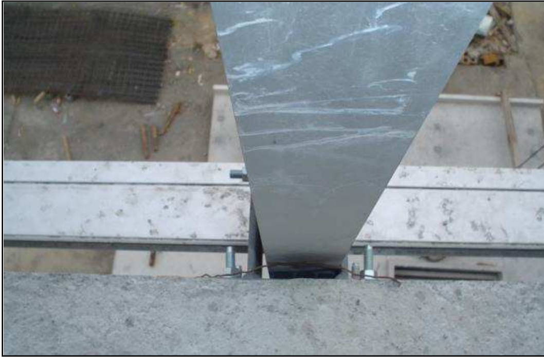
Fotografía 3. Llegada de los dos perfiles horizontales, birloancas con expansor y la holgura para ajustes del perfil vertical.
