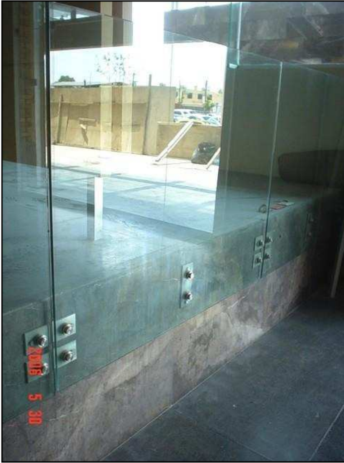
Fotografía 25 Barandal con placa y conector fijo.
