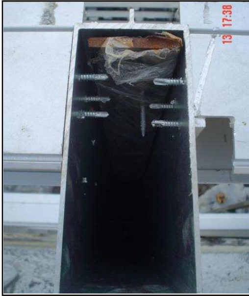
Fotografía 15. Solera de refuerzo, envuelta para evitar el par galvánico que ocurre cuando el aluminio está en contacto con el acero y las pijas que unen los perfiles horizontales con los verticales.
