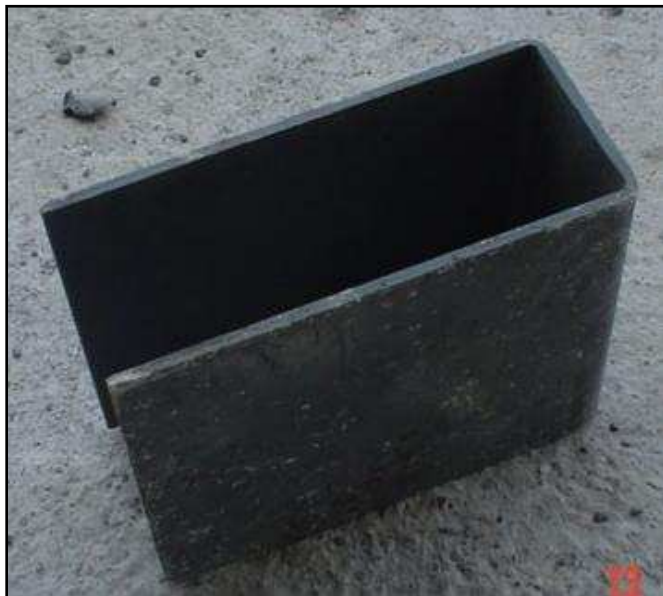
Fotografía 5. Elemento “U” que funciona como conector, va en las uniones de los elementos verticales.
