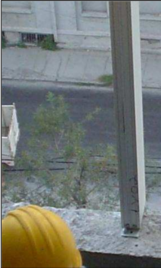
Fotografía 13. Un perfil y su escuadra de armado que según la clave que viene (LV-02) es para sujetar los louvers.
