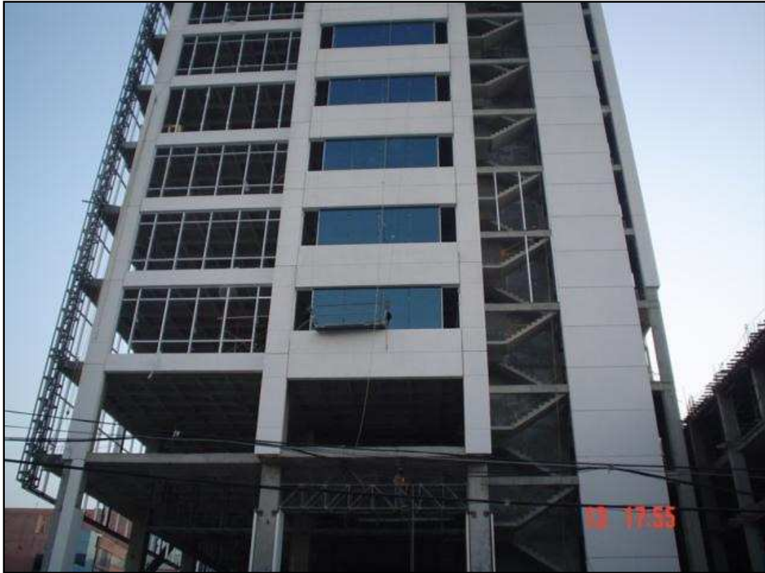
Fotografía 20. Fachada norte. Se puede apreciar el área de escaleras, la que llevará una fachada con louvers.
