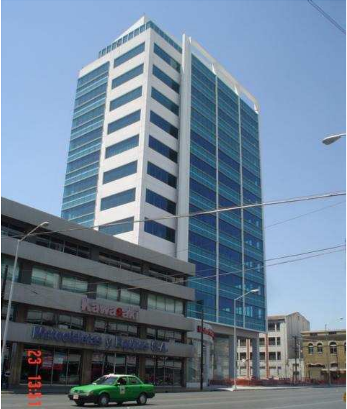
Fotografía 30. Fachada sur y oriente de Motomex.
