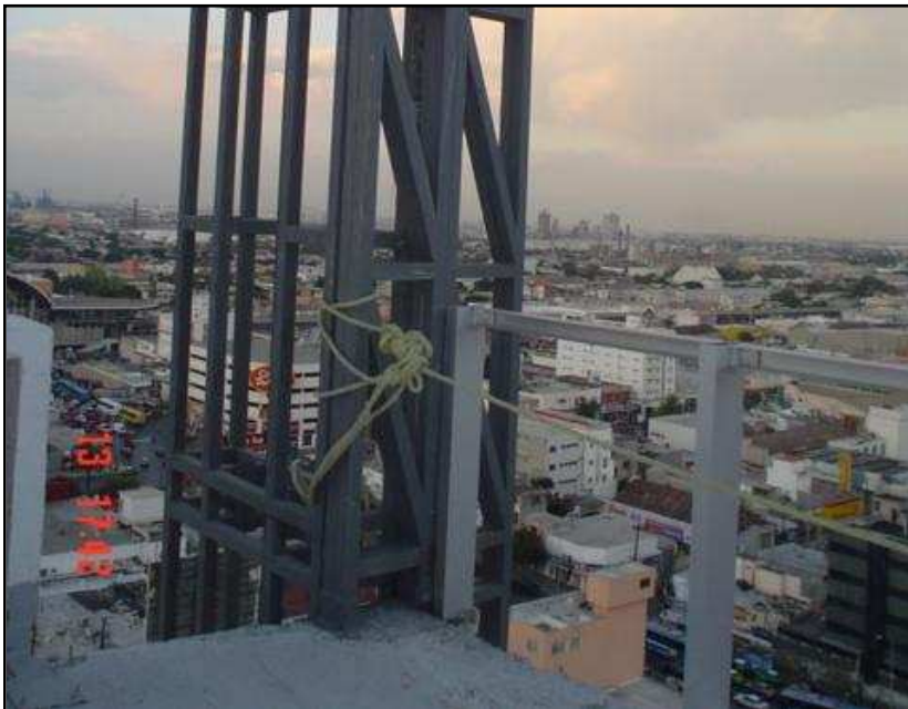
Fotografía 16. Se aprecia que el barandal es parte de la fachada integral.
