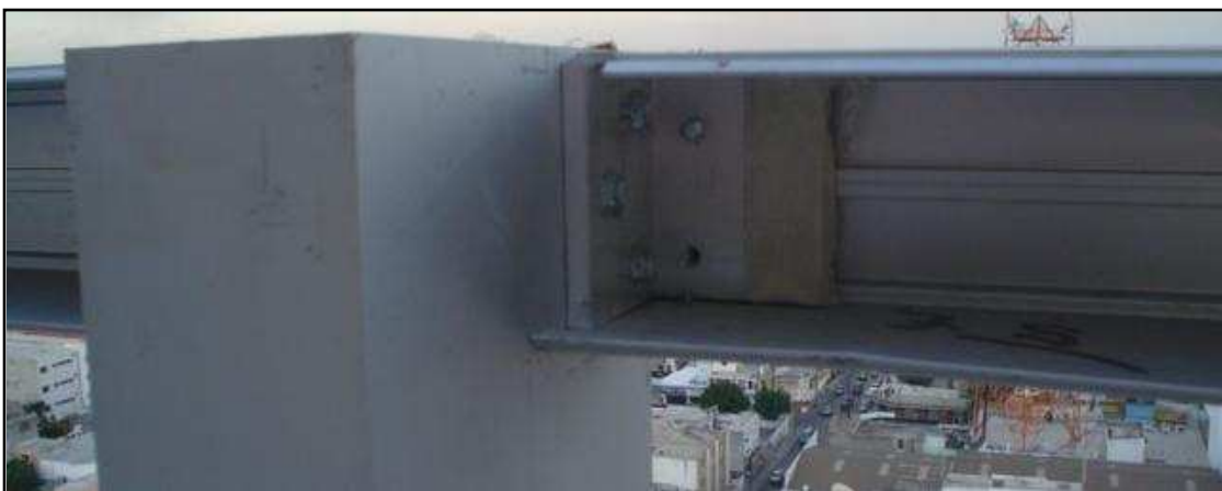
Fotografía 14. Perfil horizontal que generalmente es abierto desde la parte interior de la fachada, para así poder unirlo al elemento vertical.
