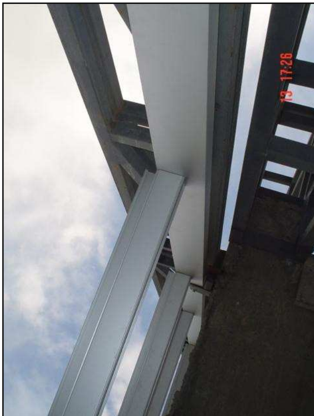
Fotografía 9. Se muestra un cancel de piso a techo.
