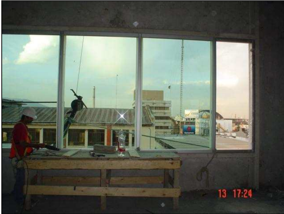
Fotografía 9. Se muestra un cancel de piso a techo.
