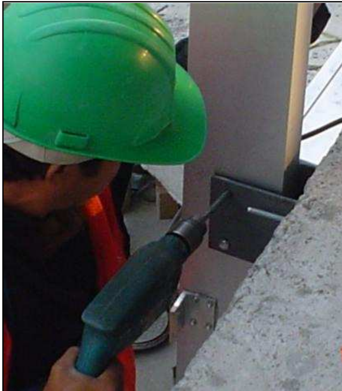
Fotografía 4. Colocación del anclaje. La escuadra de aluminio sirve para recibir el perfil horizontal.
