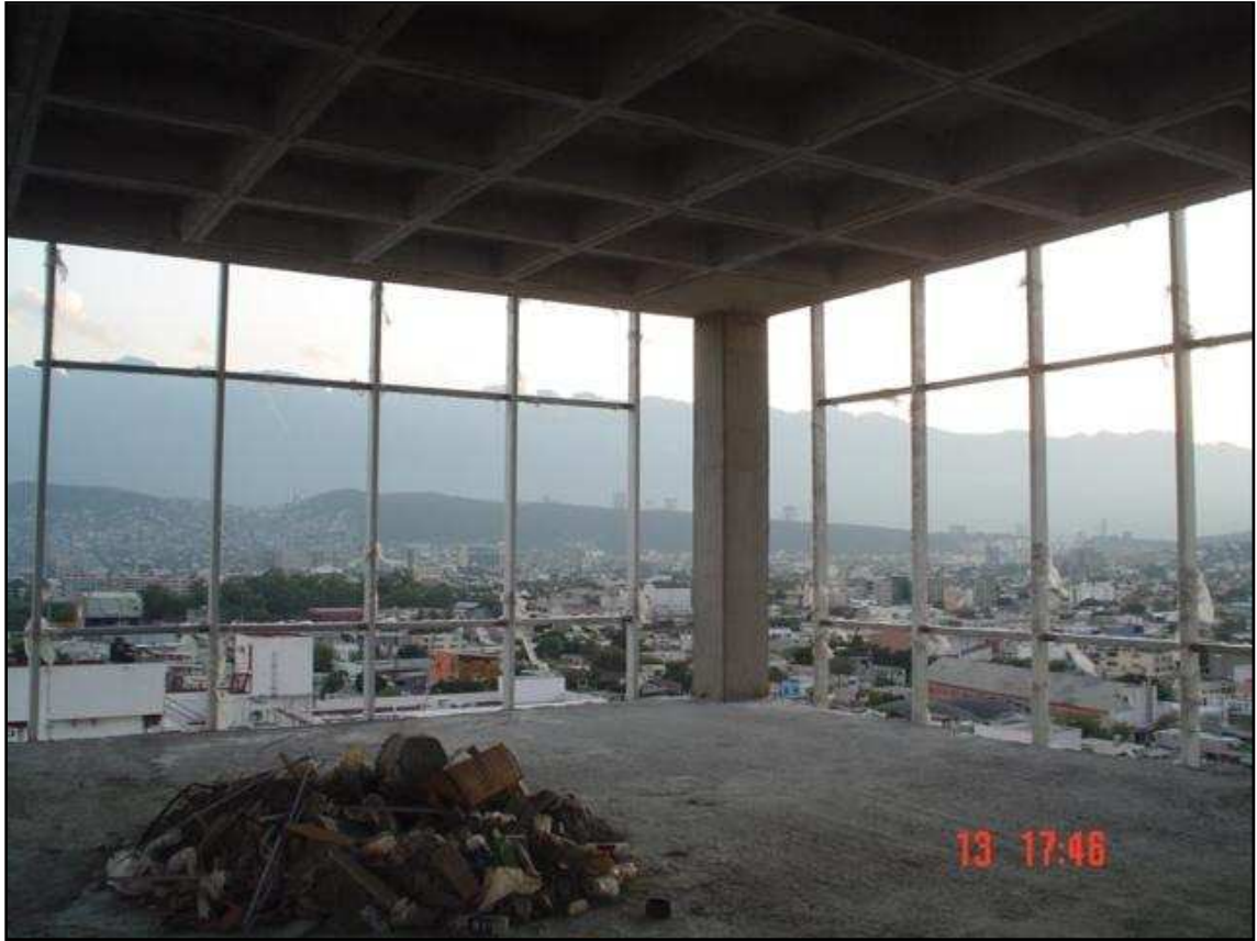
Fotografía 17. Área donde se puede ver que están colocados todos los perfiles de aluminio, tanto verticales como horizontales.
