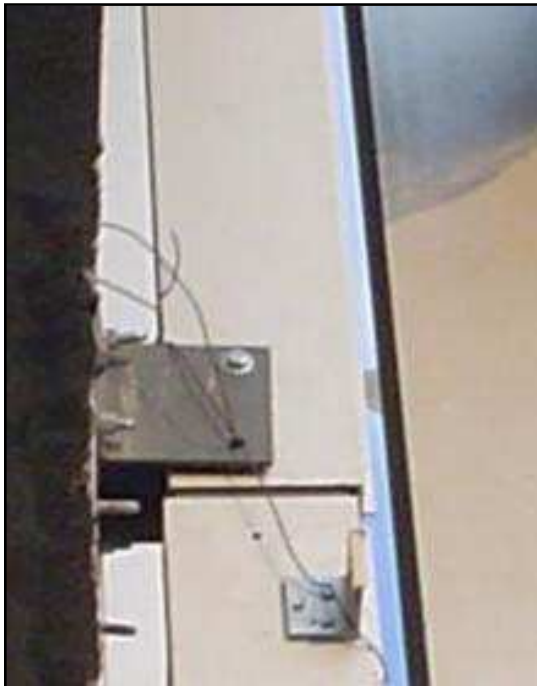
Fotografía 8. Unión de los elementos verticales. Ahí es donde va el conector; la separación entre los elementos verticales sirve para la junta de expansión.
