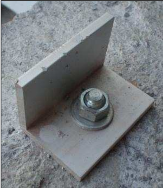
Fotografía 11. Escuadra de armado de aluminio fijada a la losa, con ancla de expansión.
