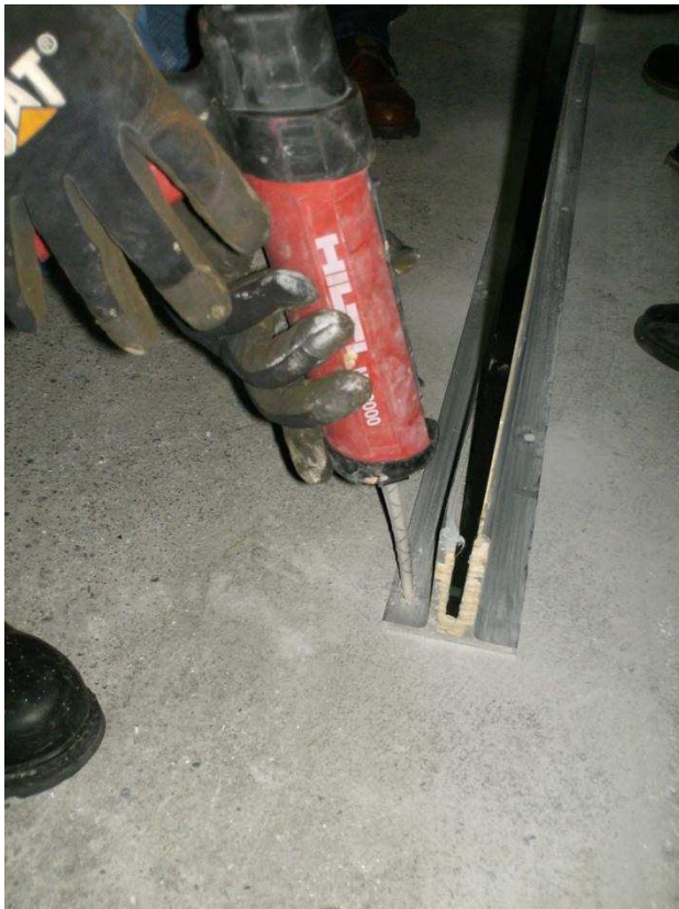
Fotografía 22. Fijación del zoclo al piso.
