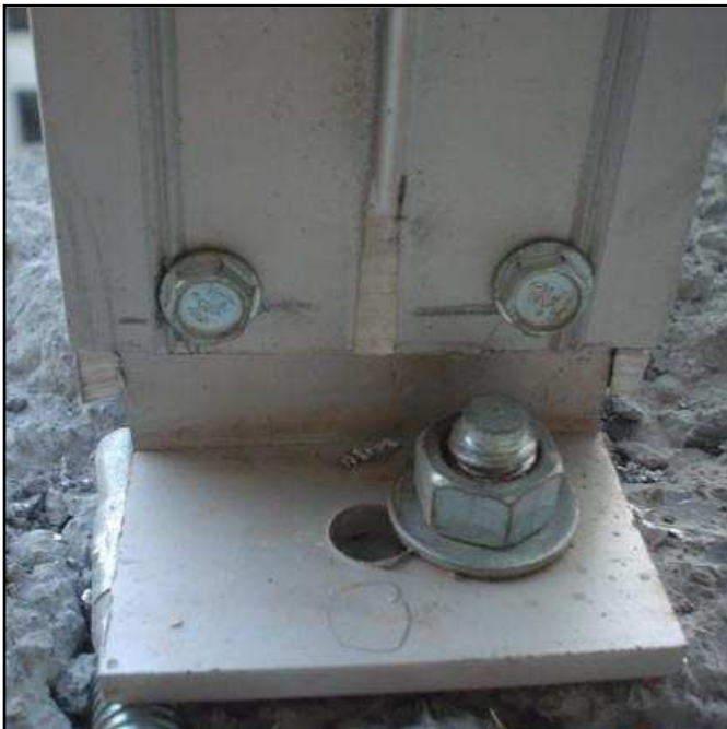
Fotografía 12. Pijas que unen el perfil vertical con la escuadra de armado y el ancla de expansión.
