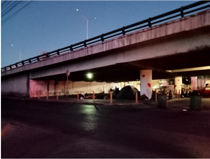
Figura 1.15 Condiciones de hacinamiento y poca higiene en los bajos del puente de la avenida “Dr. José Eleuterio González” frente al Hospital Universitario en Monterrey, Nuevo León, México. Fecha: 13 de marzo de 2022. Fuente: José Antonio González Espinoza.
