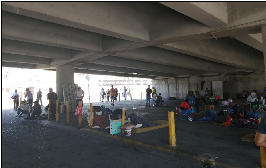
Figura 3.4 Realización de estancias temporales en la zona del bajopuente de la Av. “Gonzalitos” frente al acceso HU por parte de los familiares de pacientes. 24 de septiembre de 2021.
