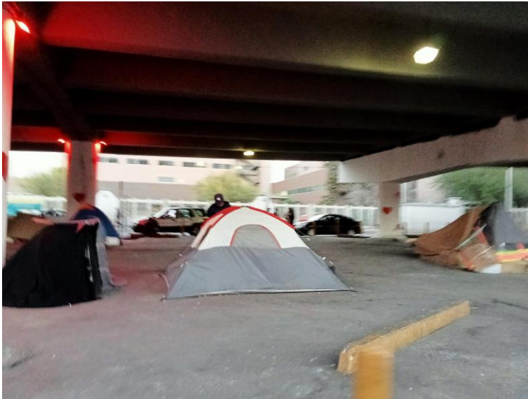
Figura 1.16 Condiciones de hacinamiento y poca higiene en los bajos del puente de la avenida “Dr. José Eleuterio González” frente al Hospital Universitario en Monterrey, Nuevo León, México. Fecha: 23 de marzo de 2022. Fuente: José Antonio González Espinoza.
