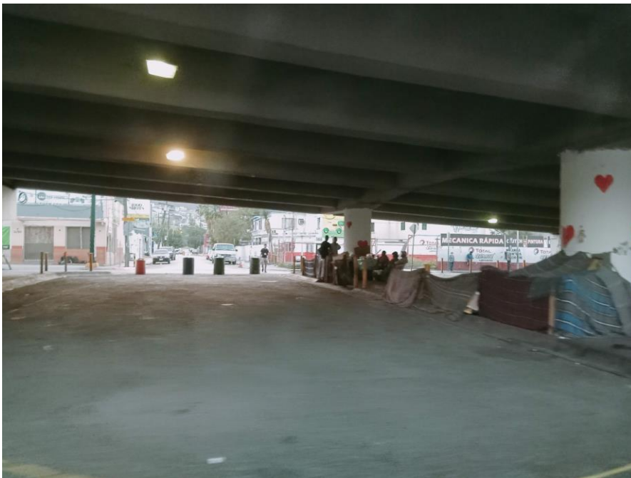
Figura 1.18 Condiciones de hacinamiento y poca higiene en los bajos del puente de la avenida “Dr. José Eleuterio González” frente al Hospital Universitario en Monterrey, Nuevo León, México. Fecha: 03 de abril de 2022. Fuente: José Antonio González Espinoza.
