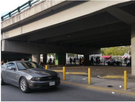
Figura 1.9 Condiciones de poca higiene en los bajos del puente de la avenida “Dr. José Eleuterio González” frente al Hospital Universitario en Monterrey, Nuevo León, México. Fecha: 01 de junio de 2021. Fuente: José Antonio González Espinoza.
