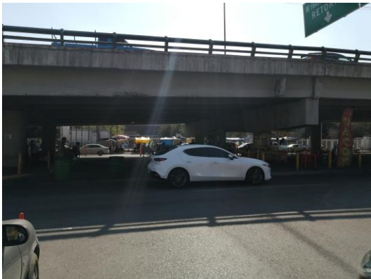
Figura 1.14 Condiciones de poca higiene en los bajos del puente de la avenida “Dr. José Eleuterio González” frente al Hospital Universitario en Monterrey, Nuevo León, México. Fecha: 24 de septiembre de 2021. Fuente: José Antonio González Espinoza.
