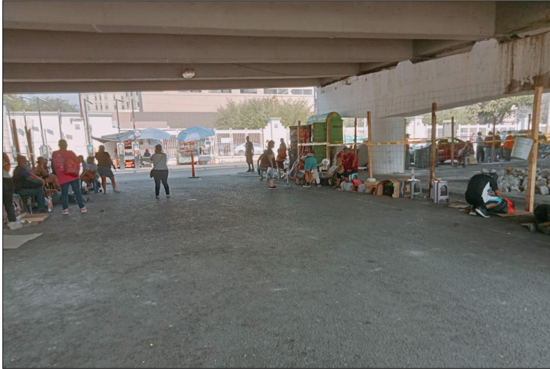
Figura 2.5 Condiciones de hacinamiento y poca higiene en el bajopuente de la avenida “Dr. José Eleuterio González” frente al Hospital Universitario en Monterrey, Nuevo León, México.
