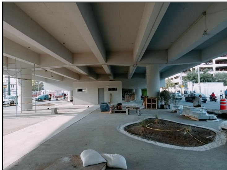
Figura 3.40 Fotografía tomada el día 09 de septiembre de 2022 en la zona del bajopunte de la Av. Gonzalitos frente al HU, durante la realización de obras de construcción en el lugar.
