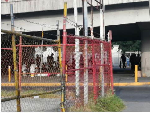
Figura 1.12 Condiciones de poca higiene en los bajos del puente de la avenida “Dr. José Eleuterio González” frente al Hospital Universitario en Monterrey, Nuevo León, México. Fecha: 05 de septiembre de 2021. Fuente: José Antonio González Espinoza.
