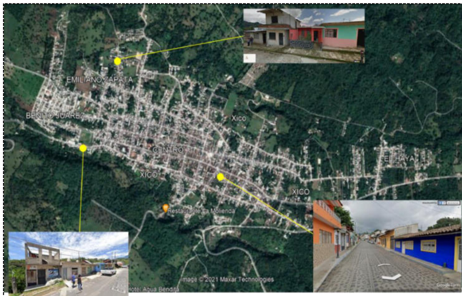
Ilustración 41 Tipología de vivienda en la cabecera municipal de Xico. Fuente: Google Earth (2021).
