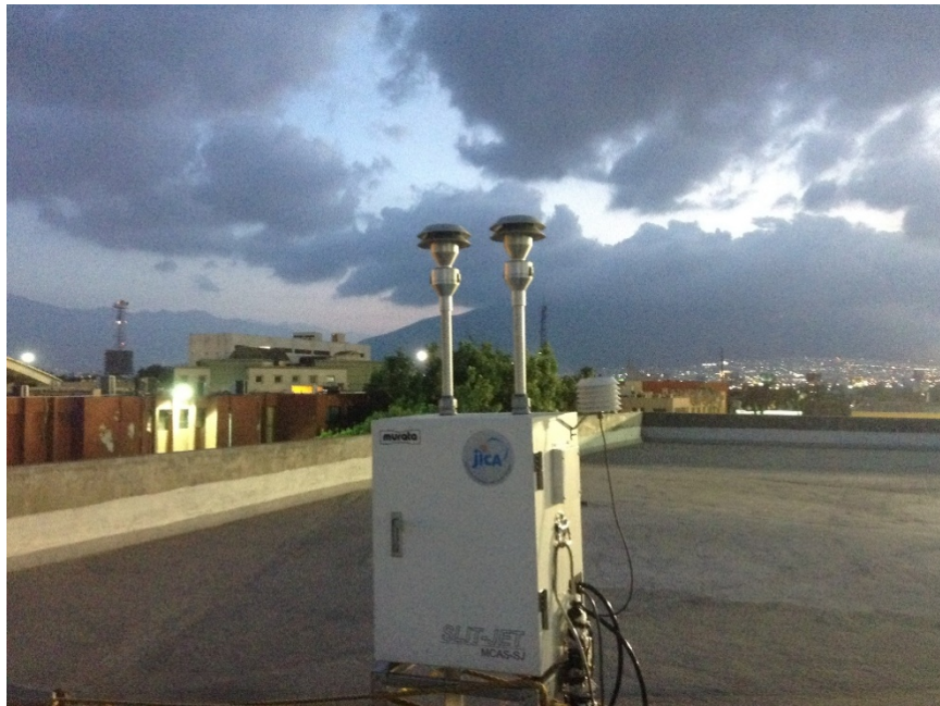
Figura 24. Equipo Air Sampler sobre el edificio del CICFIM.
