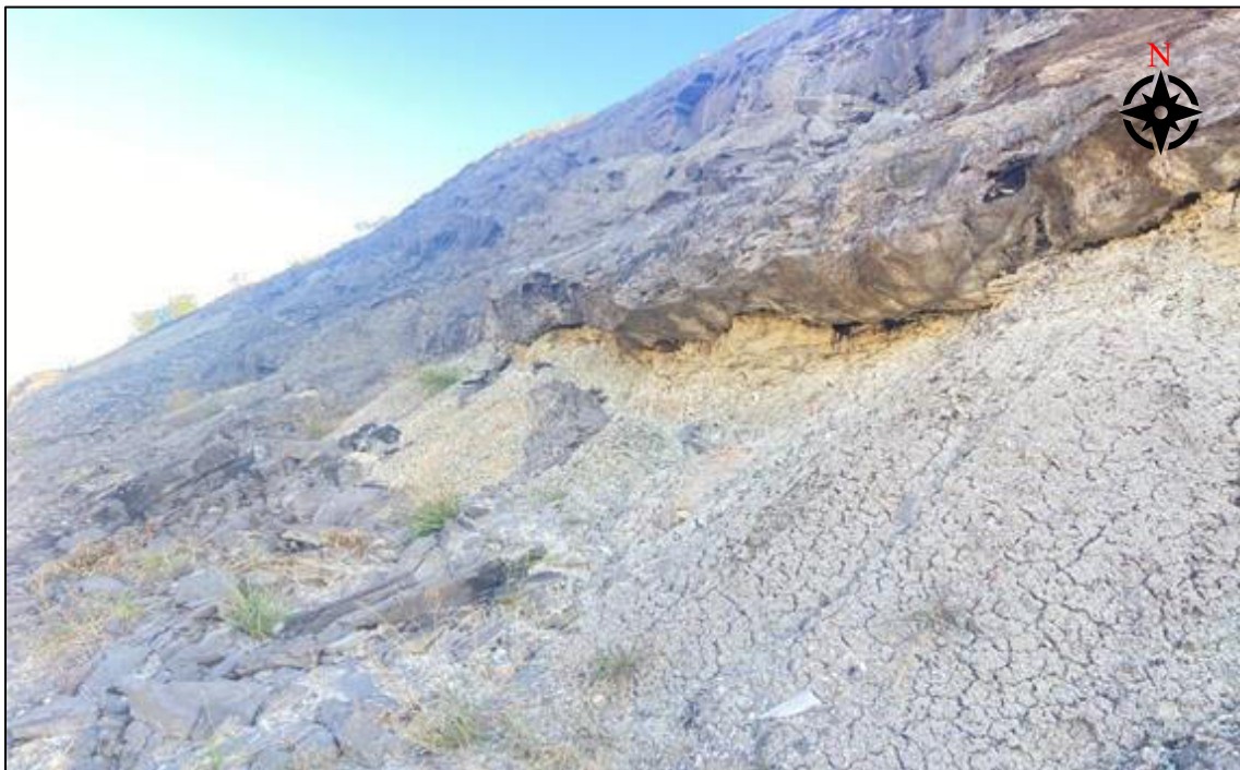
Fig. 8: Autopista Tuxpan - Tampico, Km 60. Punto 1 Coordenadas 21.370294, -97.653682
