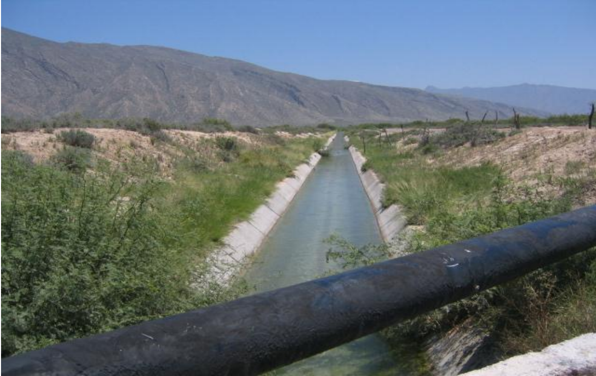
Figura No. III.5.- Canal La Becerra construido en 1966.
