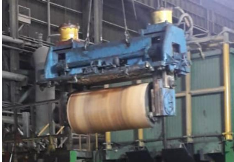
Figura 29. Instalación de pinch roll superior en el MC3
