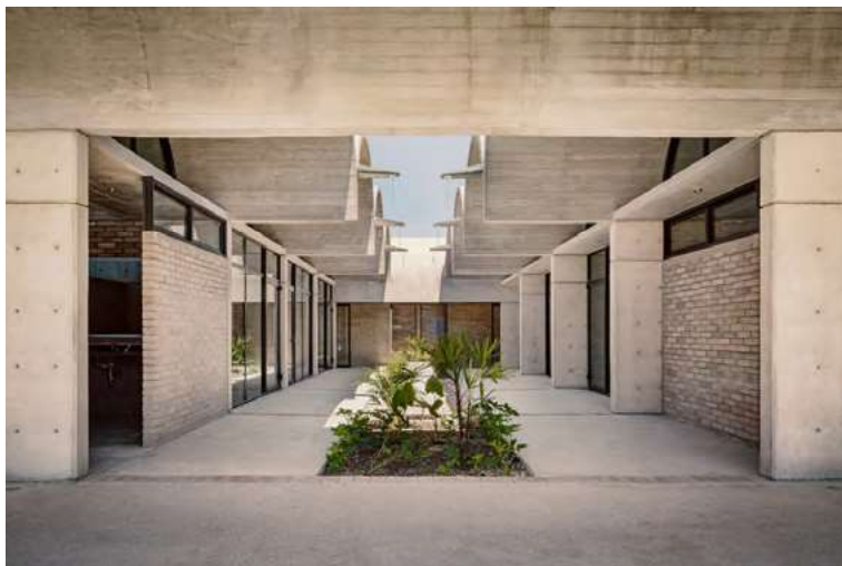
Figura 8. Centro de salud N1, por Kiltro Polaris Arquitectura + JC Arquitectura, en Escárcega, Campeche
