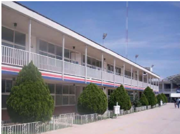
Gráfico 4. Uso previo: Escuela primaria. Edificio modulado.
