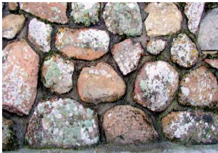
Figura 7. Muro de mampostería mixta [26].
