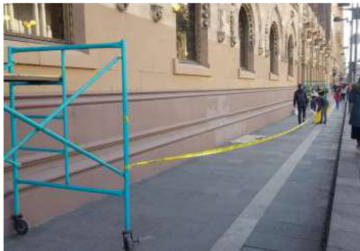
Figura 19. Restauración del Palacio Postal con \text{Ca}(\text{OH})_2 , CDMX [54].
