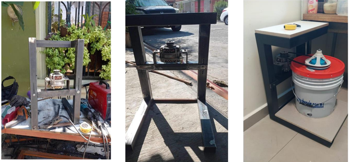
Figura A 2. Construcción de la base del biodigestor.
