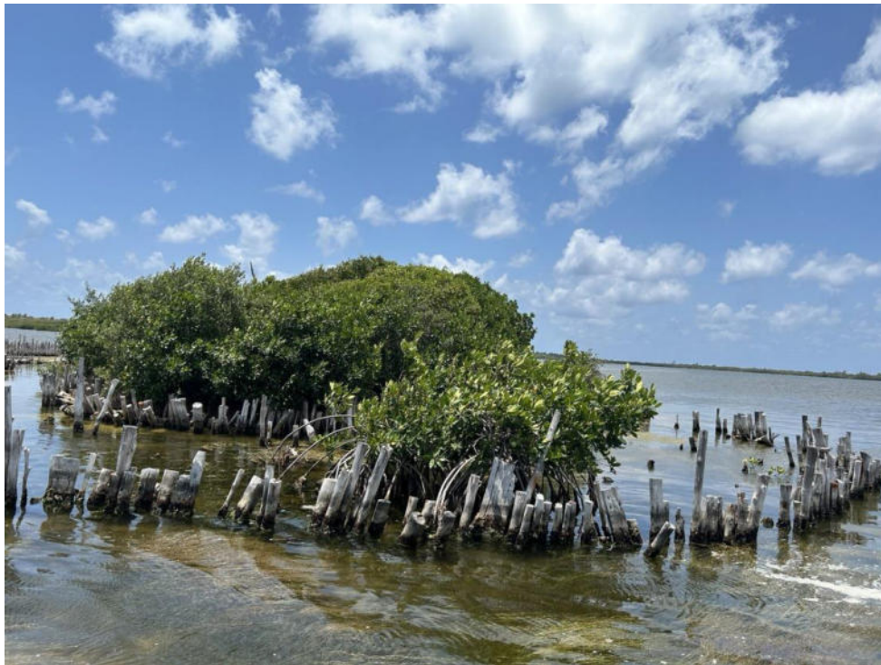
Método de fijación de sedimento en medio de la laguna para el establecimiento de mangles.
