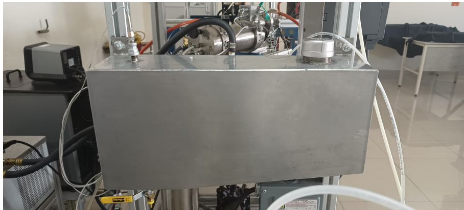
Figura 4.2: Depósito de combustible del sistema de inyección.
