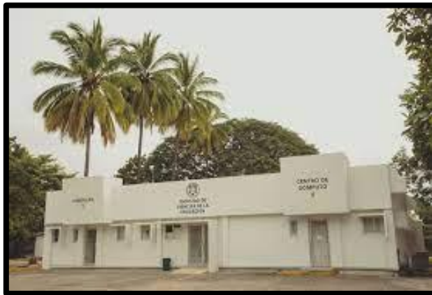
Figura 2. Frente de las instalaciones del laboratorio de fuerza
