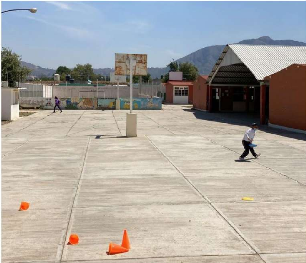
Esta imagen representa la escuela primaria que no tiene techo en la cancha.
