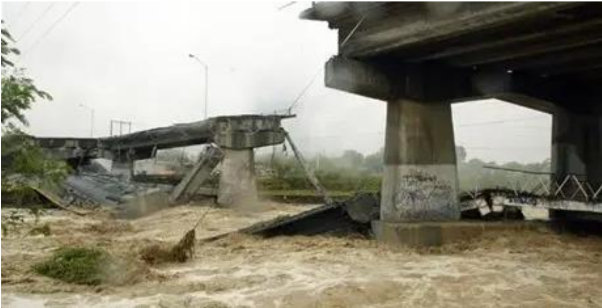
Figura 6.2. Daños causados en Monterrey por huracán Emily. Tomada de Periódico Hoy.
