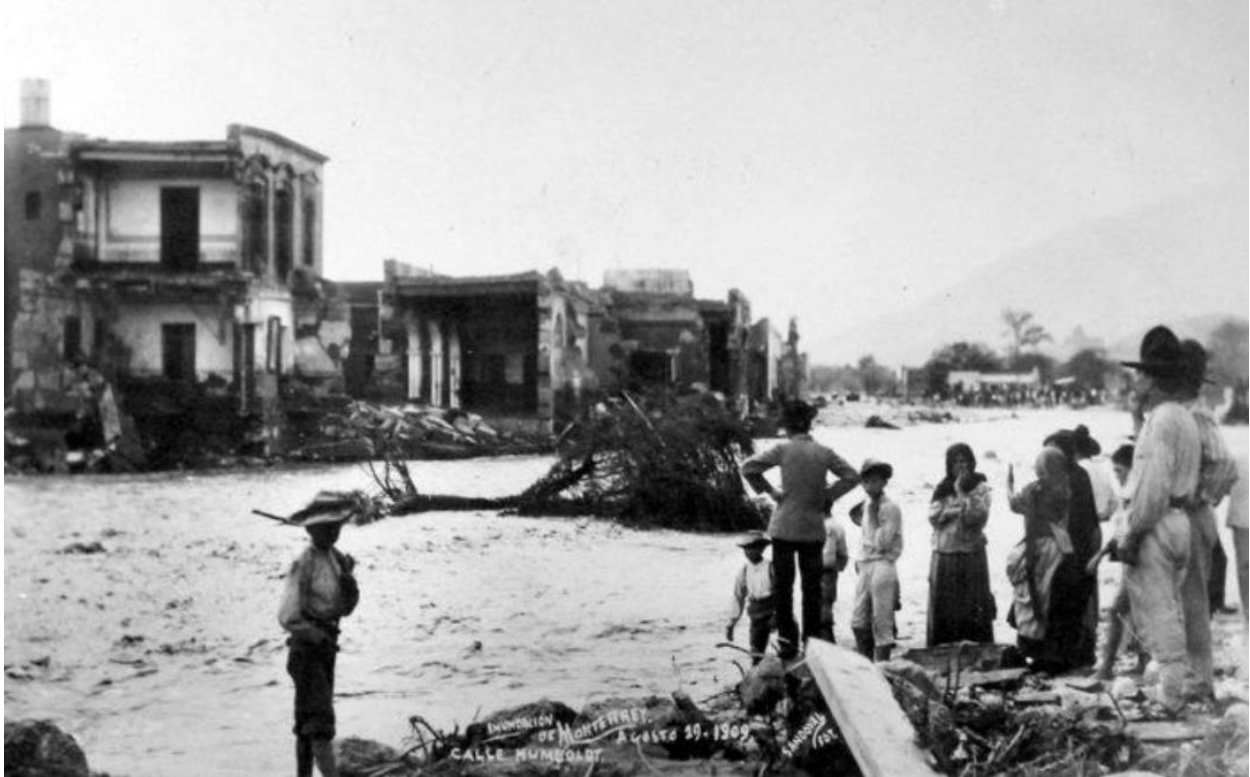
Figura 6.8. Daños causados por la inundación de 1909, Barrio Antigo. Tomada de CICNL, 2021.
