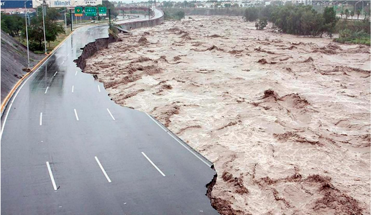
Figura 6.3. Daños causados por el huracán Alex en 2010. Tomada de Centro Nacional de Prevención de Desastres: Gobierno de México.
