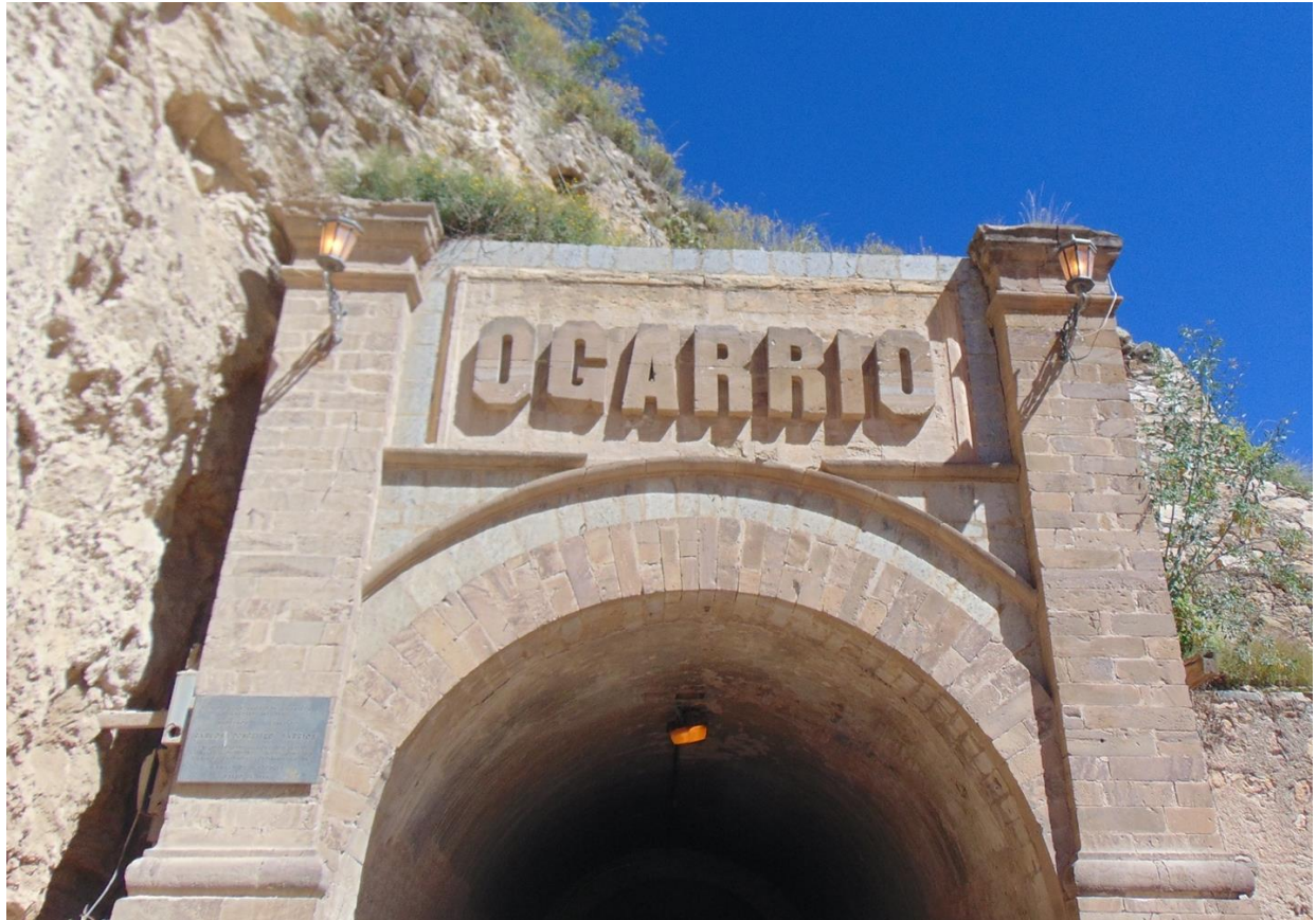
Figura 2.4. Túnel Ogarrío, Real de Catorce, San Luis Potosí.
