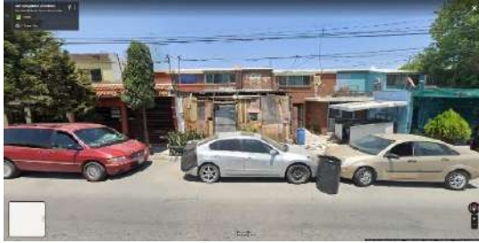
Imagen 43. Trabajadores Cetemistas, vivienda en deterioro.
