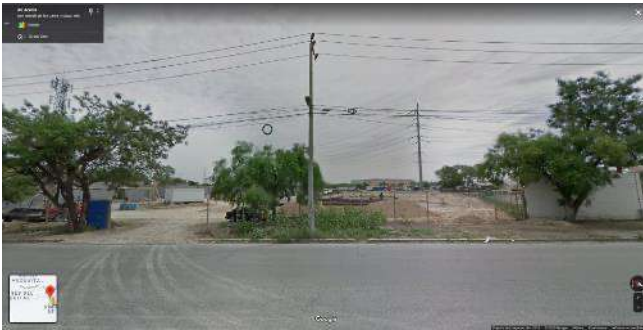
Imagen 44. Terrenos en construcción para Industria, Av. aceros.
