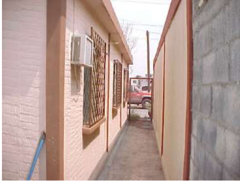
Foto 6. Vista del pasillo hacia la calle
