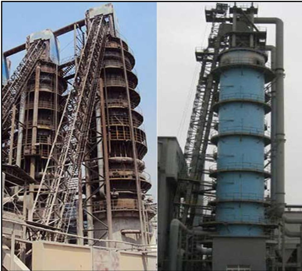
*Figura 1. Hornos verticales para la producción de clínker de cemento.*
