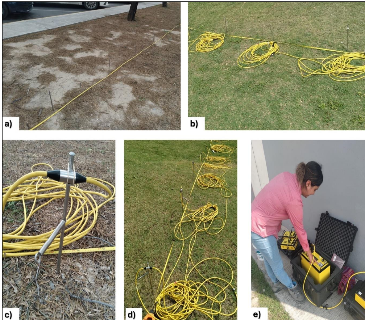
Figura 33. Instalación de las líneas geofísicas en campo: a) se colocan las estacas de acero inoxidable a lo largo del perfil, b) se coloca cada cable con una estaca, c) electrodo formado a partir del sensor del cable multi-electrodo y una estaca, d) electrodos formados a largo del perfil, e) se configura el equipo con los parámetros necesarios para la medición.
