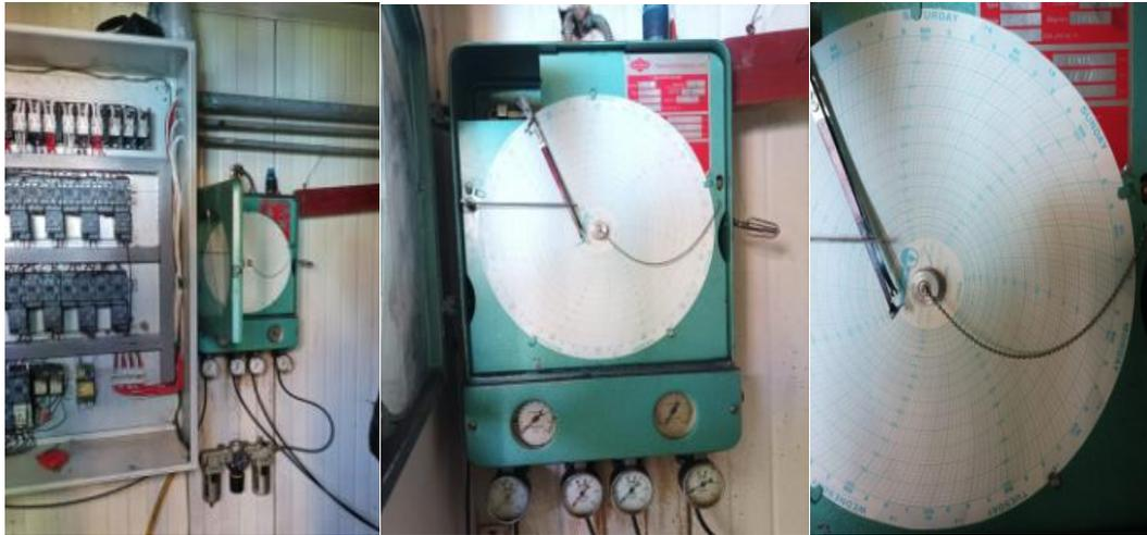
Figura 1. 3. Registro de un secador antiguo en el estado de Durango, México. La recopilación de datos es limitada, propensa a errores humanos y a las condiciones físicas del lugar en el que se encuentra.
