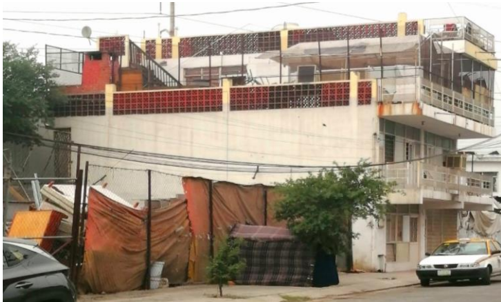
Figura 18. Casa comunitaria en la colonia Bella Vista, donde se ha utilizado hasta la azotea como área de vivienda para migrantes, en su mayoría haitianos. Fuente: Elaboración propia.
