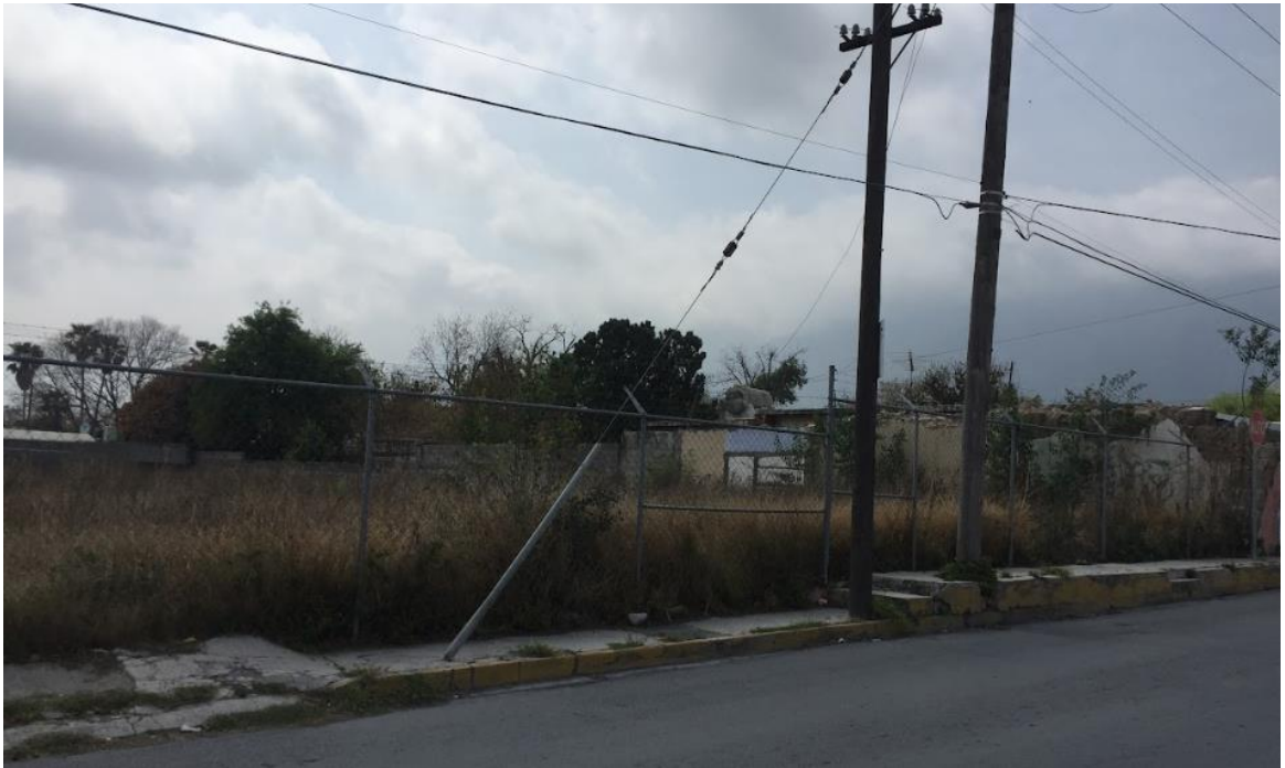
Figura 52 Predio baldío donde existía una vivienda.
