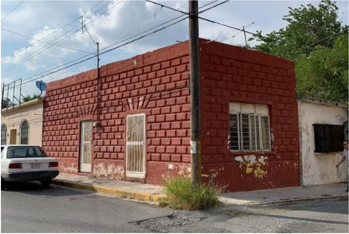
Figura 48 Vivienda con detalle almohadillado o aborregado
