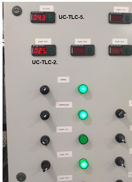
FIGURA 4.8: Panel de control del sistema calorímetro.
