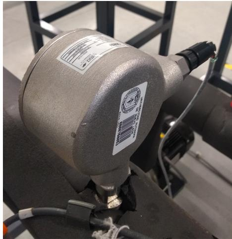
FIGURA 4.7: Instrumento UC-TS-3 medidor de flujo volumétrico.
