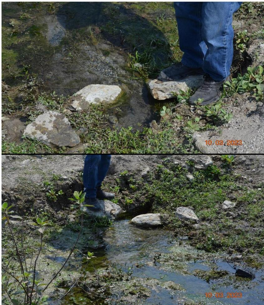
Figura 92. Manantial localizado aguas debajo de V – 3 en la medición de marzo 2023, con 13 % de volumen de llenado de la presa.
