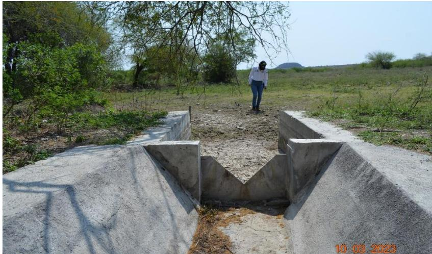
Figura 91. V – 3 durante la campaña de medición de marzo 2023, con 13 % de volumen de llenado de la presa.
