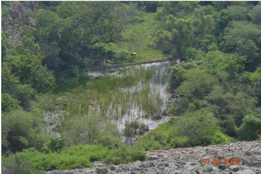
Figura 93. Vista hacia el pie de la cortina de la presa donde se observa la presencia de filtraciones.
