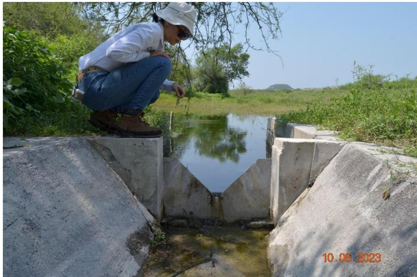
Figura 94. V – 3 con presencia de filtraciones en el mes de junio 2023, con 17 % de llenado de la presa.
