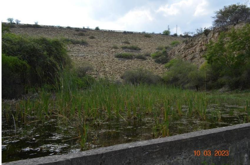
*Figura 89. Zona de filtraciones al pie de la cortina con presencia de tule y carrizo, marzo 2023 con 13 % de volumen de llenado de la presa.*
