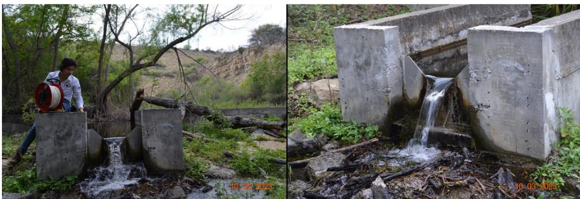
Figura 88. Localización de filtraciones en V – 1, marzo 2023 con 13 % de volumen de llenado de la presa.
