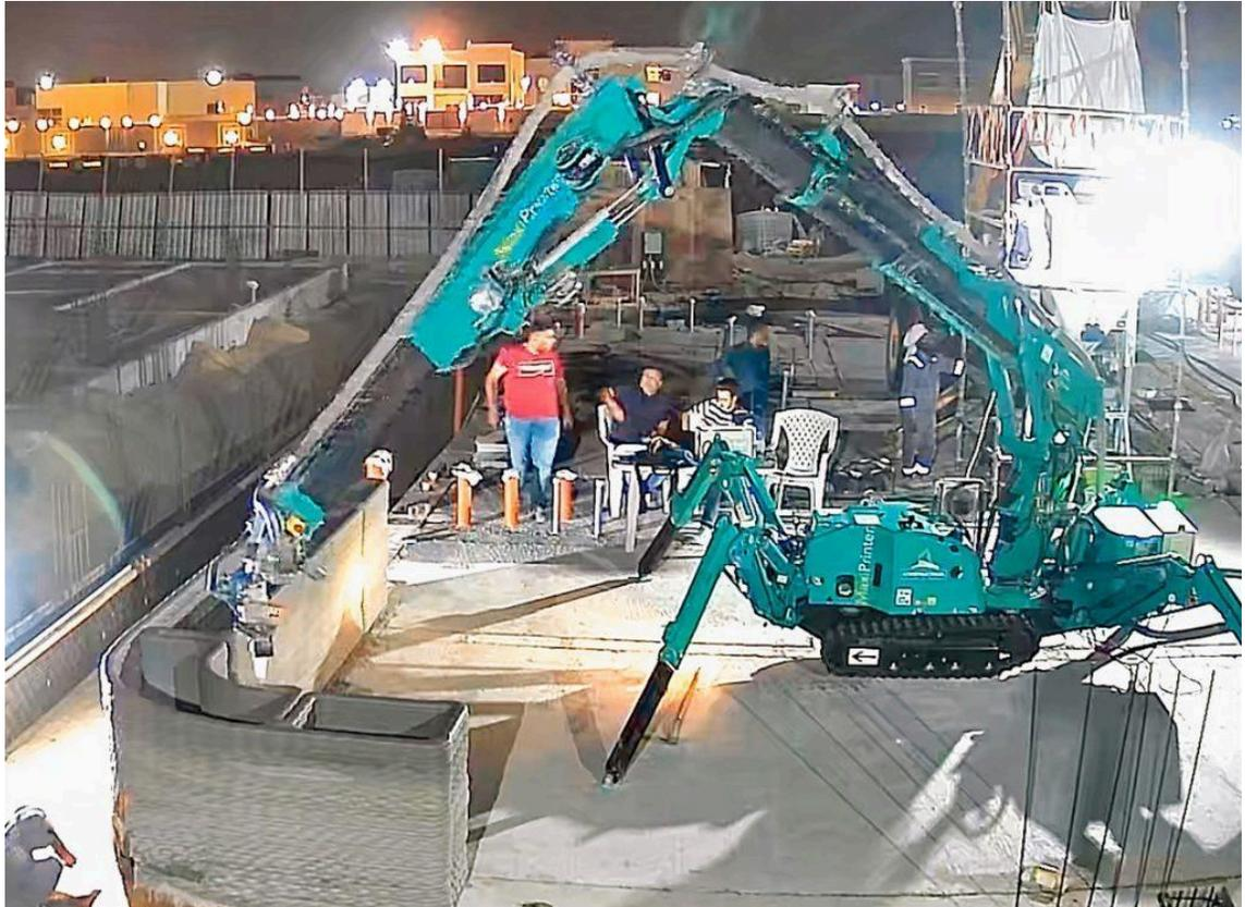
**Figura 9.** La impresora 3D MaxiPrinter, producida por Construccions 3D, móvil y compacta [29]
