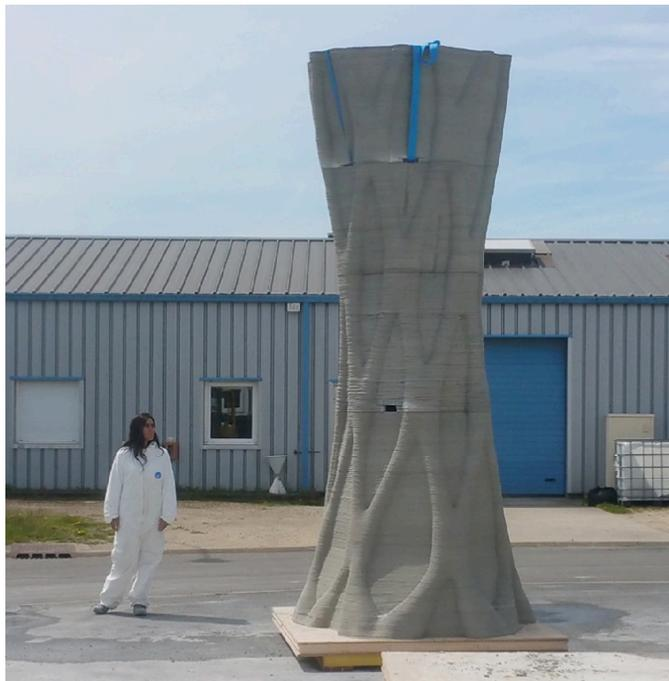
**Figura 2.** Elemento estructural de concreto impreso en Francia. [9]
