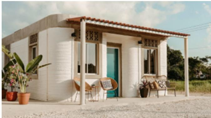
**Figura 1.** Vivienda de concreto impreso en localidad rural en Tabasco, México, como parte de un vecindario de 50 viviendas. [8]
