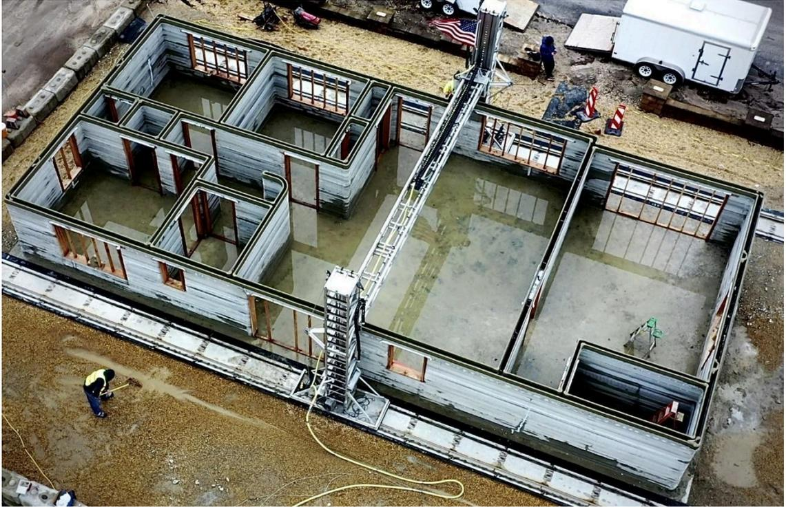
**Figura 5.** Vivienda de concreto impresa en Nueva York por SQ4D, de 1900 pies cuadrados de construcción. [14]
