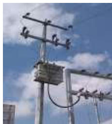
Figura 6. Aisladores de la porcelana montados en una subestación eléctrica.
