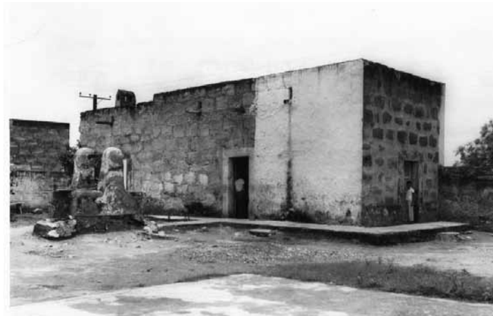
Inmueble que albergó la escuela primaria en San Miguel.
