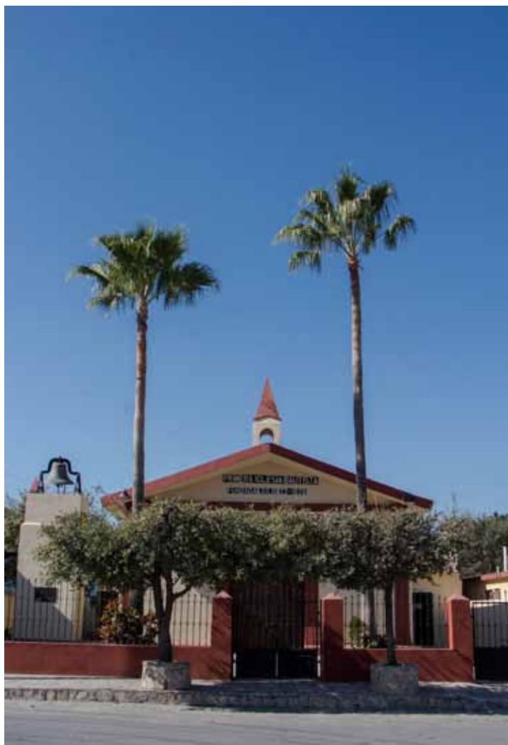
Fachada de la primera iglesia bautista de Apodaca fundada en 1870.
