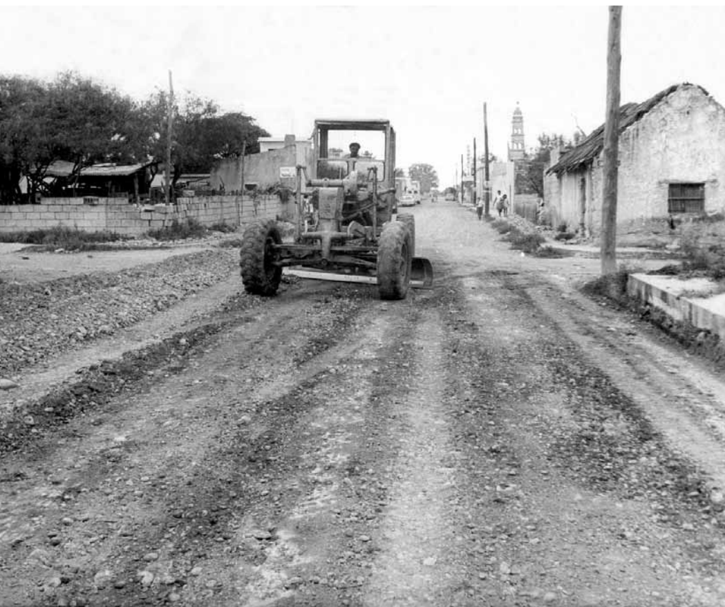
Maquinaria poniendo grava en la calle Morelos del centro de Apodaca.
