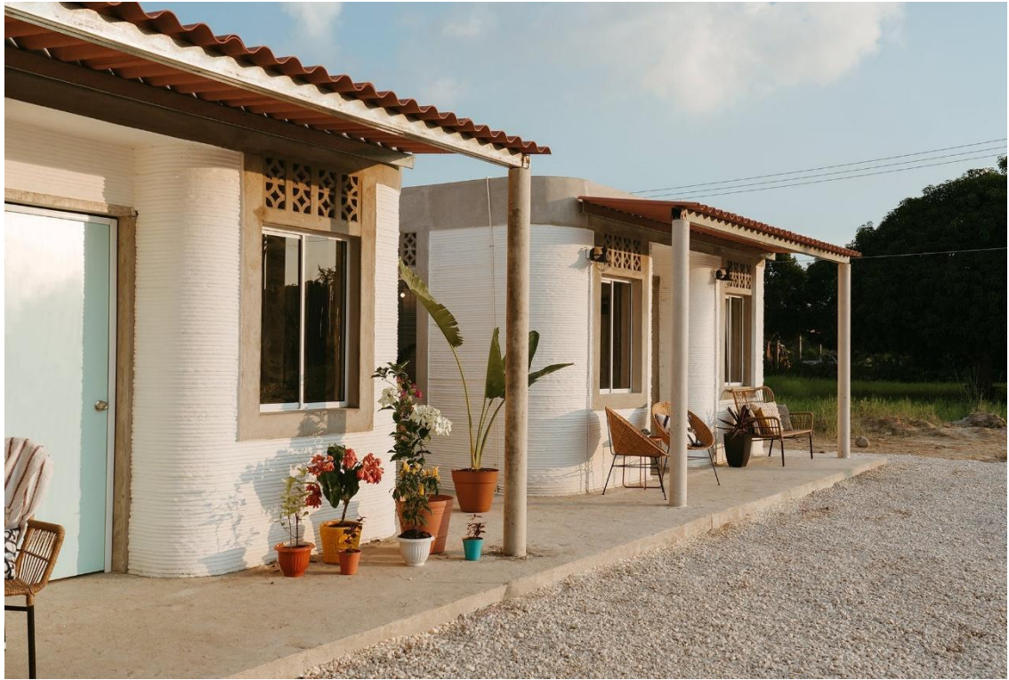
Figura 5. Viviendas impresas en 3D construidas por ICON en Nacajuca, México en el año 2019 [64] .
