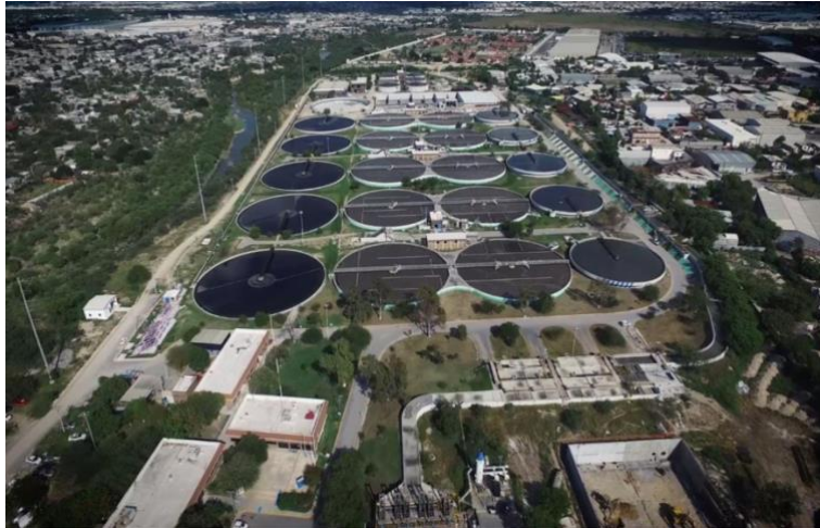
Figura 11. PTAR Norte de Agua y Drenaje de Monterrey. Reimpresión de Servicios de Agua y Drenaje de Monterrey (2023)
